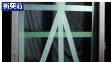
養生テープで対策した 複層ガラス
